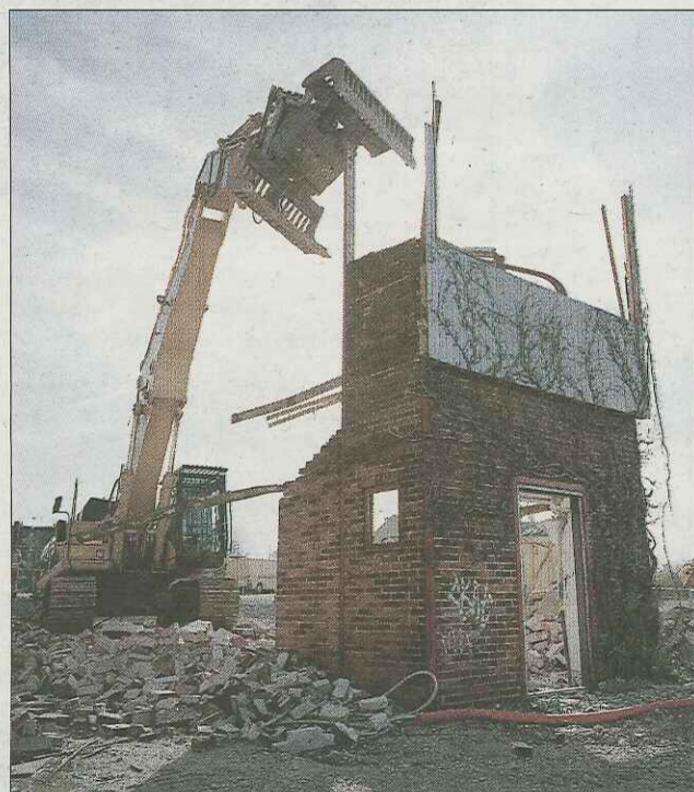
Bam-bus skal hjælpe med at forbedre arbejdsmiljø og sikkerhed på byggepladserne. FOTO: SIMON LADEFOGED
